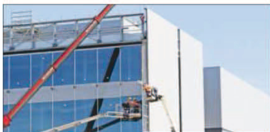
Die Bauarbeiten bei der „Factory 56“ laufen auf Hochbetrieb
